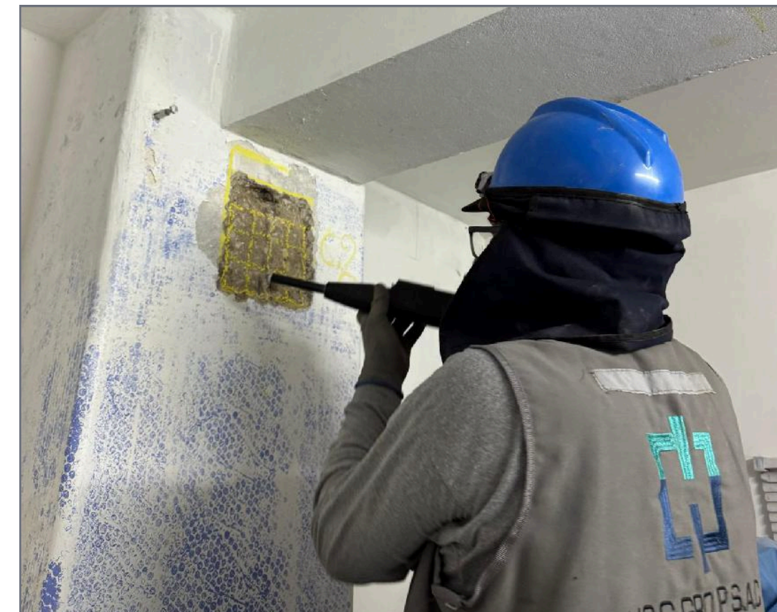
Ensayos no destructivos (esclerometría, detección de acero)
