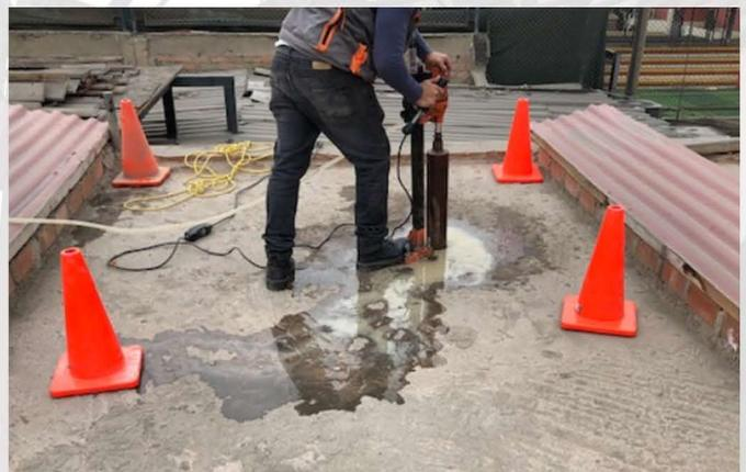
Extracción de núcleos de concreto con diamantina
