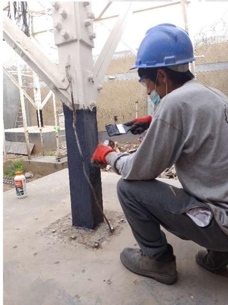
Aplicación de inhibidor de corrosión en montante para mitigar la corrosión en el acero
