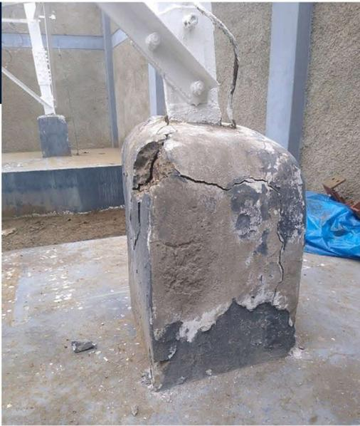
Concreto fisurado por corrosión en acero de refuerzo corroído
