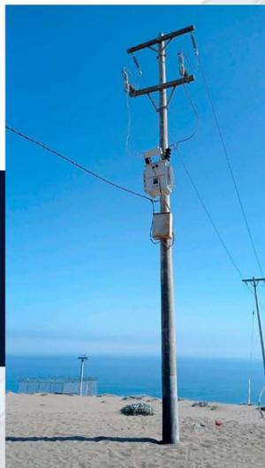
Reemplazo de transformador 25KVA en línea de meda tensión
