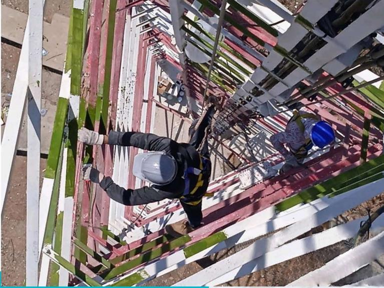
Corrección en zonas con presencia de óxido y pintado con sistema tricapa
